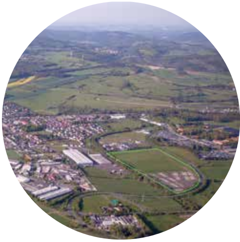
Baustart in Hessisch Lichtenau
