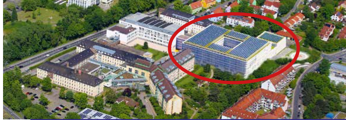
Für 150 Millionen Euro soll bis 2031 der Neubau des EKW entstehen. Foto: EKW
