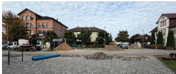
Bau des neuen Kreisels
