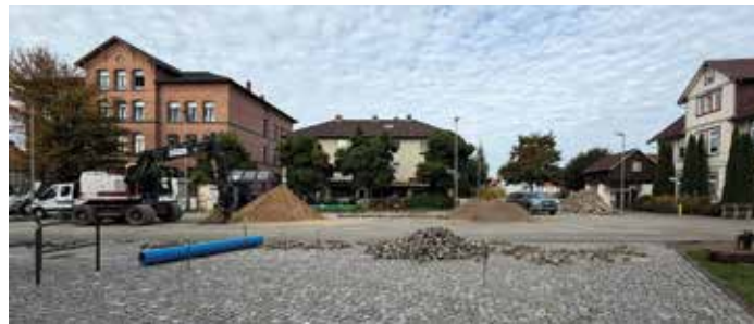
Bau des neuen Kreisels
