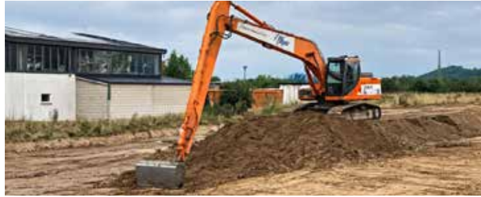
Bagger im Einsatz an der Baustelle in Wulften. Foto mit KI erstellt
