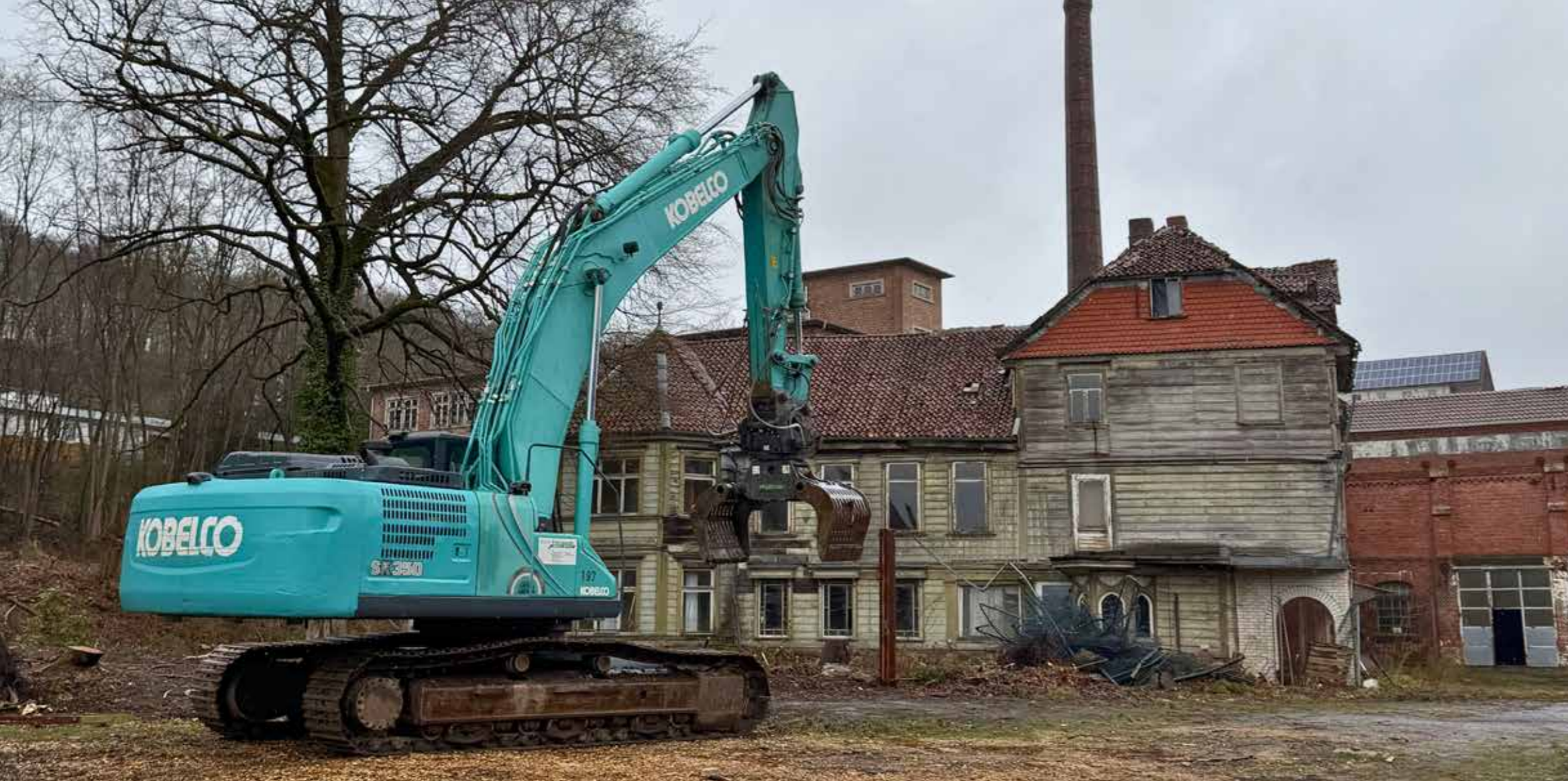
Wollwarenquartier im Wandel: Stadt Osterode startet Abrissarbeiten. Foto: Stadt Osterode
