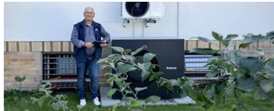
Carsten Wettig von den Versorgungsbetrieben Hann. Münden begleitet den Einbau dieser Wärmepumpe.
