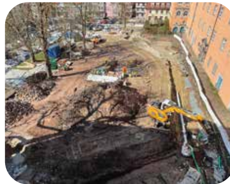
Die archäologischen Funde gelten unter Experten als außergewöhnlich. Damit sie für die Nachwelt erhalten bleiben können, wurde beschlossen, die Kanaltrasse zu verlegen.
