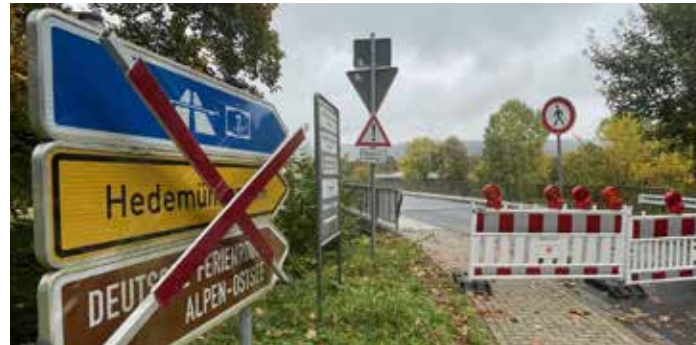
Die Werrabrücke zwischen Oberode und Hedemünden ist nach Abschluss der Bauwerksprüfung wieder für Fahrzeuge bis 16 Tonnen freigegeben.
