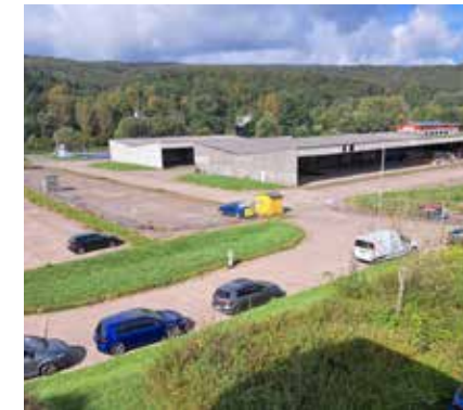
Auf dem Gelände entsteht bis Jahresende eine großflächige Photovoltaikanlage, mit der die Stadtentwässerung künftig energieautark arbeitet. Foto: Stadt HMÜ
