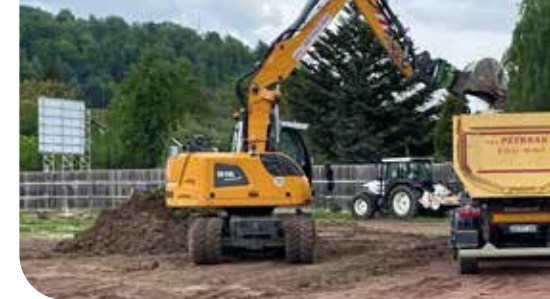
Das neue Sportgelände am Rattwerder ist im Bau.
