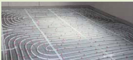
Innenaufnahme mit den gut sichtbaren Schläuchen der zukünftigen Fußbodenheizung
